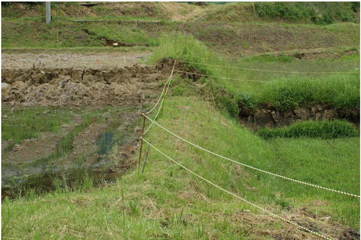
図3 〔上〕 2011年4月11日福島県東部地震（気象庁マグニチュード7.0）に伴って活動した正断層。いわき市田人町黒田。〔下〕 上の写真の右手延長部。わずかな左ずれ成分がある。
